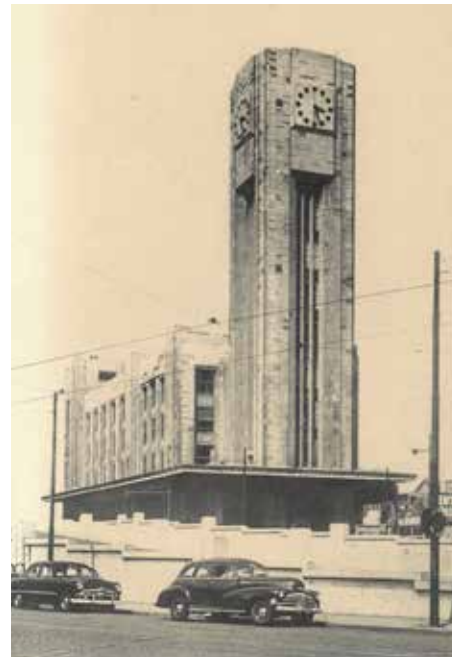
Het nieuwe Noordstation (1949-1952). Noordplein, Sint-Joost-ten-Node
